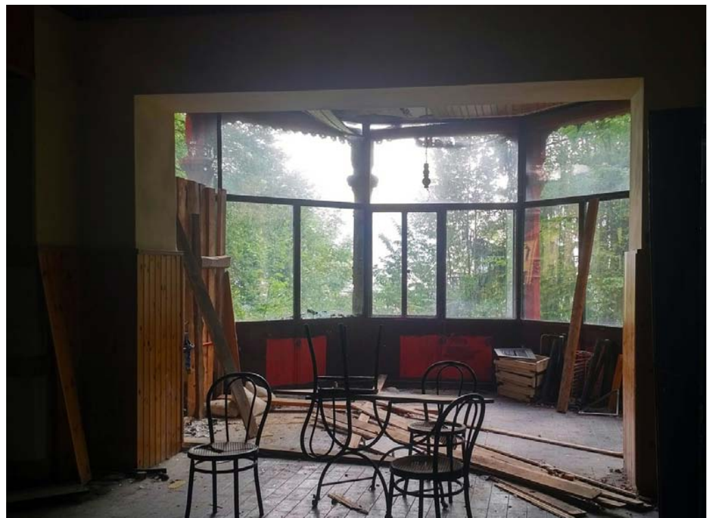
Fig. 5: Sopralluogo nell'abbandonata Villa Roi
