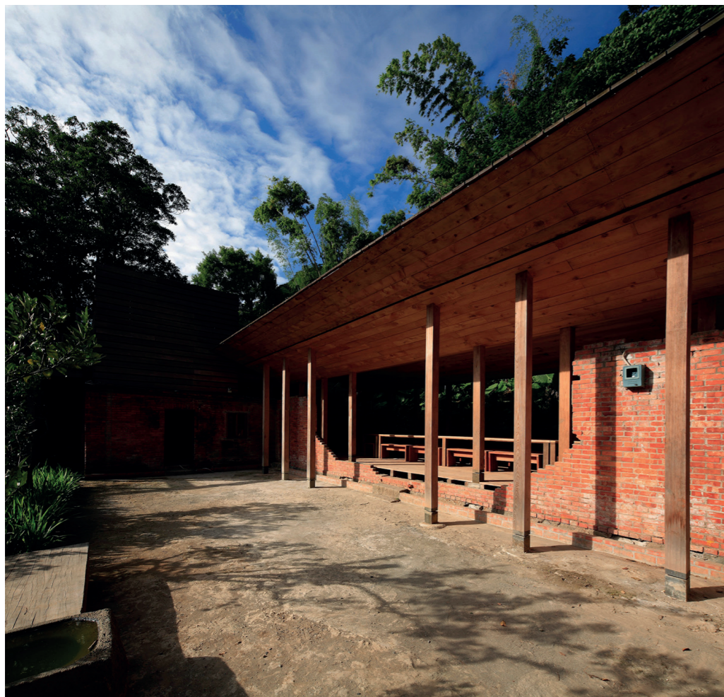
Fig. 1 – Ultra-Ruin Project, Marco Casagrande (2013). Il progettista, attraverso un riuso adattivo, definisce un'infrastruttura dell'accoglienza a partire da un edificio in rovina a Taipei City (fonte: https://www.archdaily.com/485522/ultra-ruin-marco-casagrande?ad_medium=office_landing&ad_name=article ).
