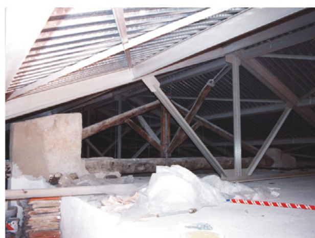
Fig. 4 e 5 - Interventi sulla capriata lignea
