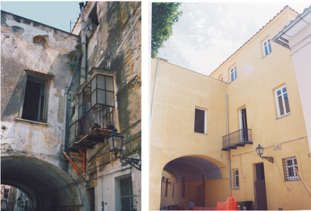
Fig. 8 e 9 - Vista del cavalcavia prima e dopo l'intervento
