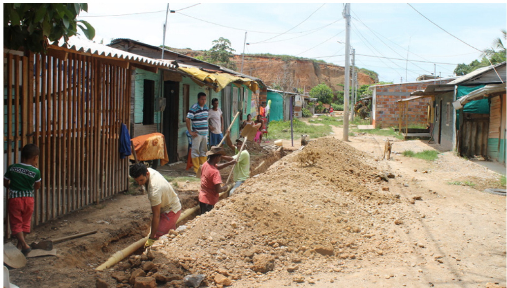
Fig. 5 - Instalación de servicios públicos. (foto D. Burbano G.)
