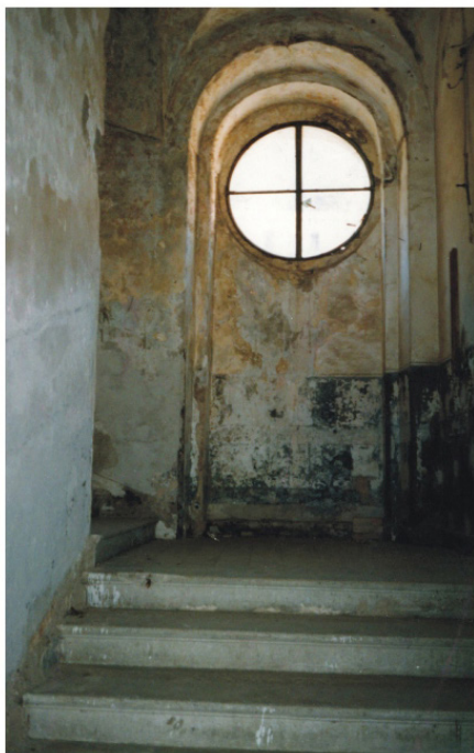
Fig. 1 - Vista del corpo scala
