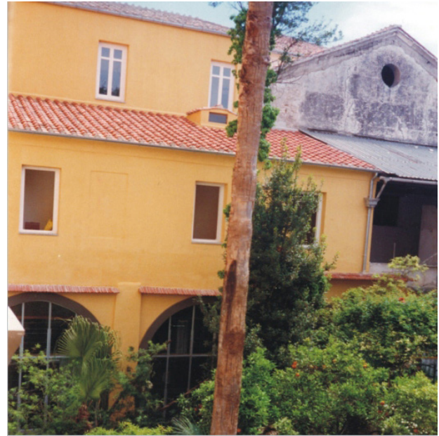
Fig. 13 - Prospetto dopo l'intervento
