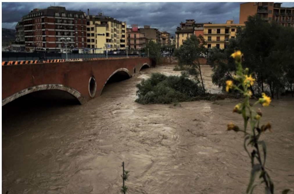
Figura 10 - Il Fiume Calore in piena giunge a sfiorare le arcate del ponte.
