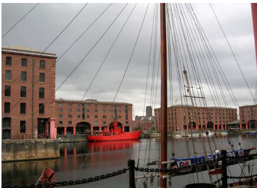
fig. nn. 2-3: Lo storico Albert Dock, a Liverpool, con la Tate Liverpool, sede della collezione nazionale di arte moderna dell'Inghilterra del nord e centro regionale di arte contemporanea, ed il Merseyside Maritime Museum, entrambi ubicati in edifici preesistenti (Foto C. Cuturi, 2006)
