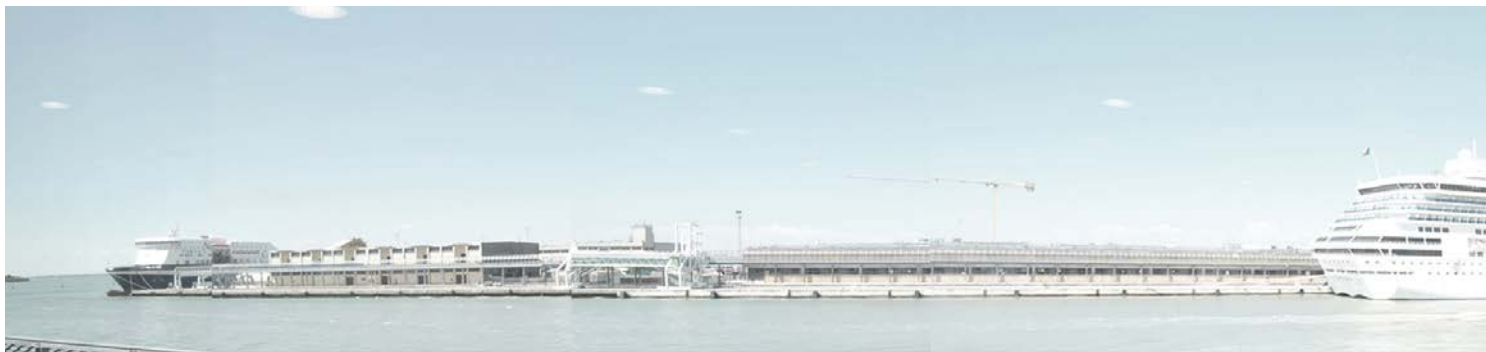
Figura 1 - Vista dei terminal sulla banchina Tagliamento
