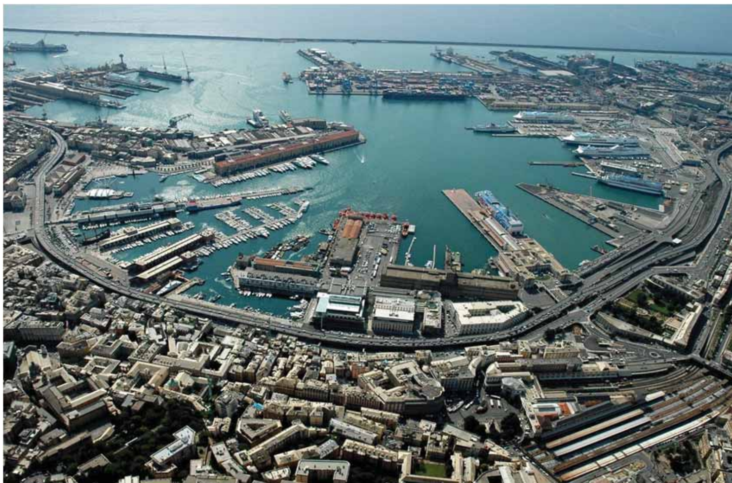
Fig. 2 – Immagine dell'area centrale del Porto di Genova (fonte Assessorato all'Urbanistica del Comune di Genova)
