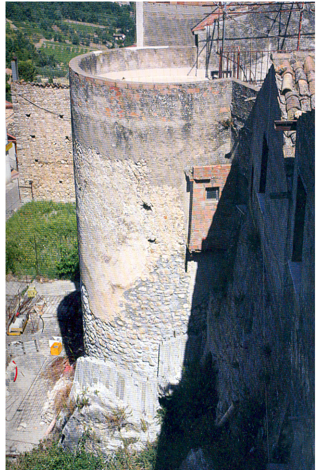
Foto n. 3 - Torrecuso, persistenza di torre della murazione medioevale
