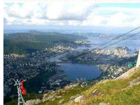
Figg. 5-6, Bergen ha rivitalizzato l'antico Bryggen (patrimonio Unesco) restaurandone gli edifici e insediandovi attività culturali, commerciali e turistiche. In coerenza con la articolata morfologia del Byfjorden, le attività portuali si sviluppano, quasi sempre, in continuità con le attività urbane.
