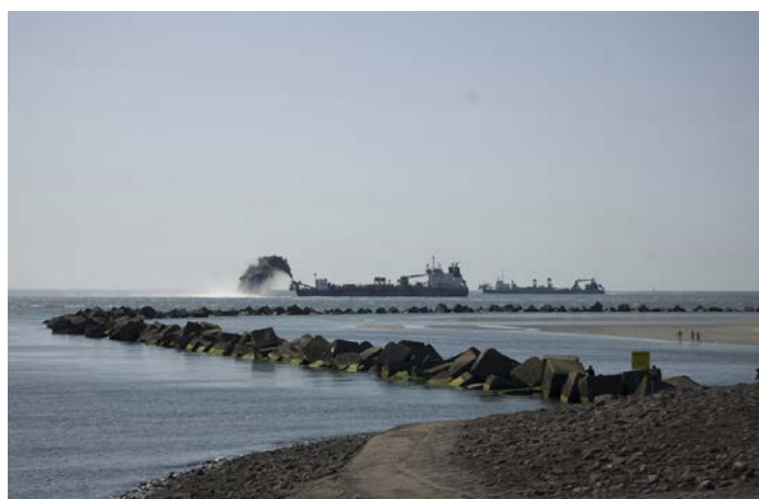
Fig. 4 Creazione di tratto di costa artificiale tramite navi aspira sabbia
