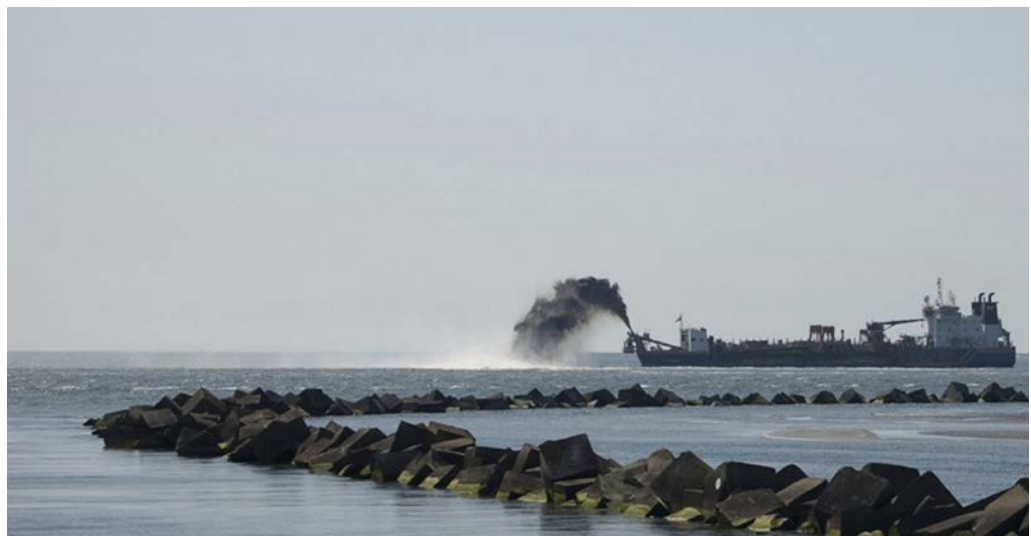
Creazione di tratto di costa artificiale tramite navi aspira sabbia
