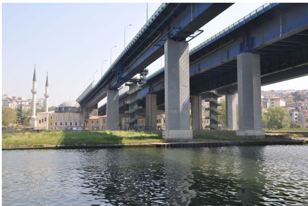
Fig. 8 - Il ponte di Haliç
