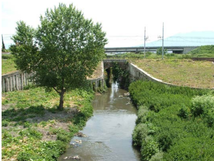
Fig. 4 Acerra. Il canale dei Regi Lagni e in alto il ponte ferroviario della linea tra Napoli-Cancello
