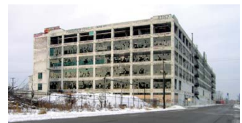
Figura 1. Fisher Body Plant 21 (Detroit). Estado actual
