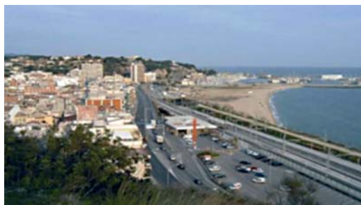
Figura 4. El Maresme, en la costa metropolitana de Barcelona, es un ejemplo de la tendencia a la conurbación de las localidades costeras y del impacto de las infraestructuras sobre el espacio litoral. En la fotografía una imagen de Arenys de Mar
