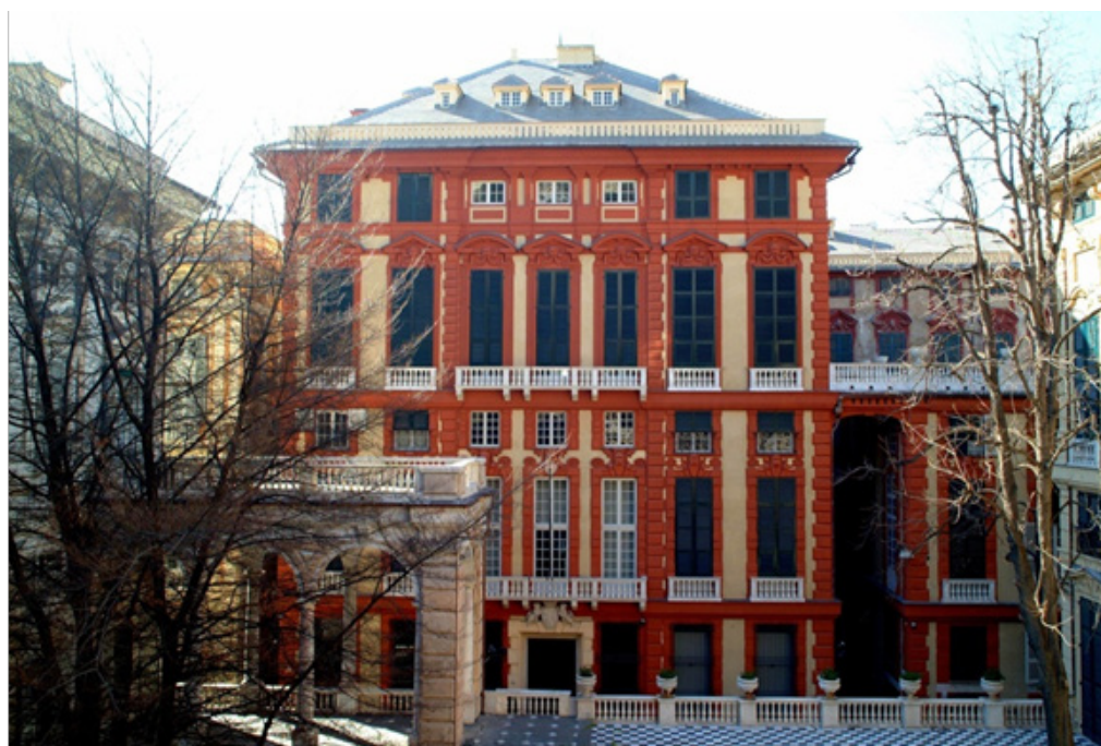
Fig. 4 – Palazzo Rosso in via Garibaldi, rifacimento della facciata nel 2004 (foto: F. Gastaldi)
