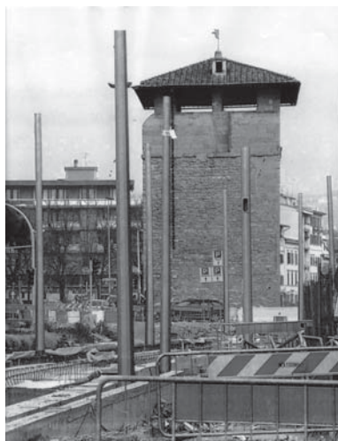
Porta al Prato nella fase di costruzione
