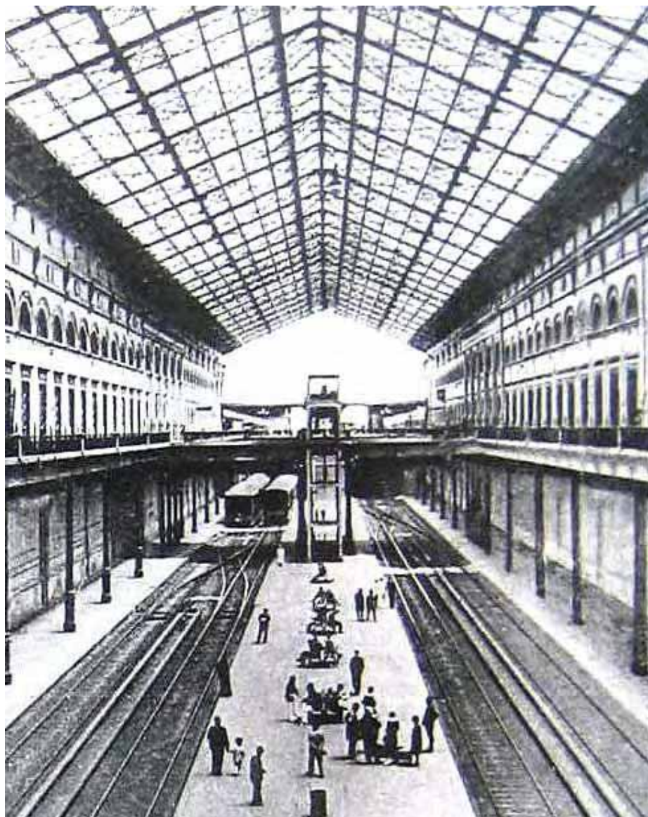
Interno della Stazione Centrale (demolita nel 1957) con la copertura in ferro e vetro realizzata su progetto di Alfredo Cottrau (da Alisio, Buccaro, 2000).
