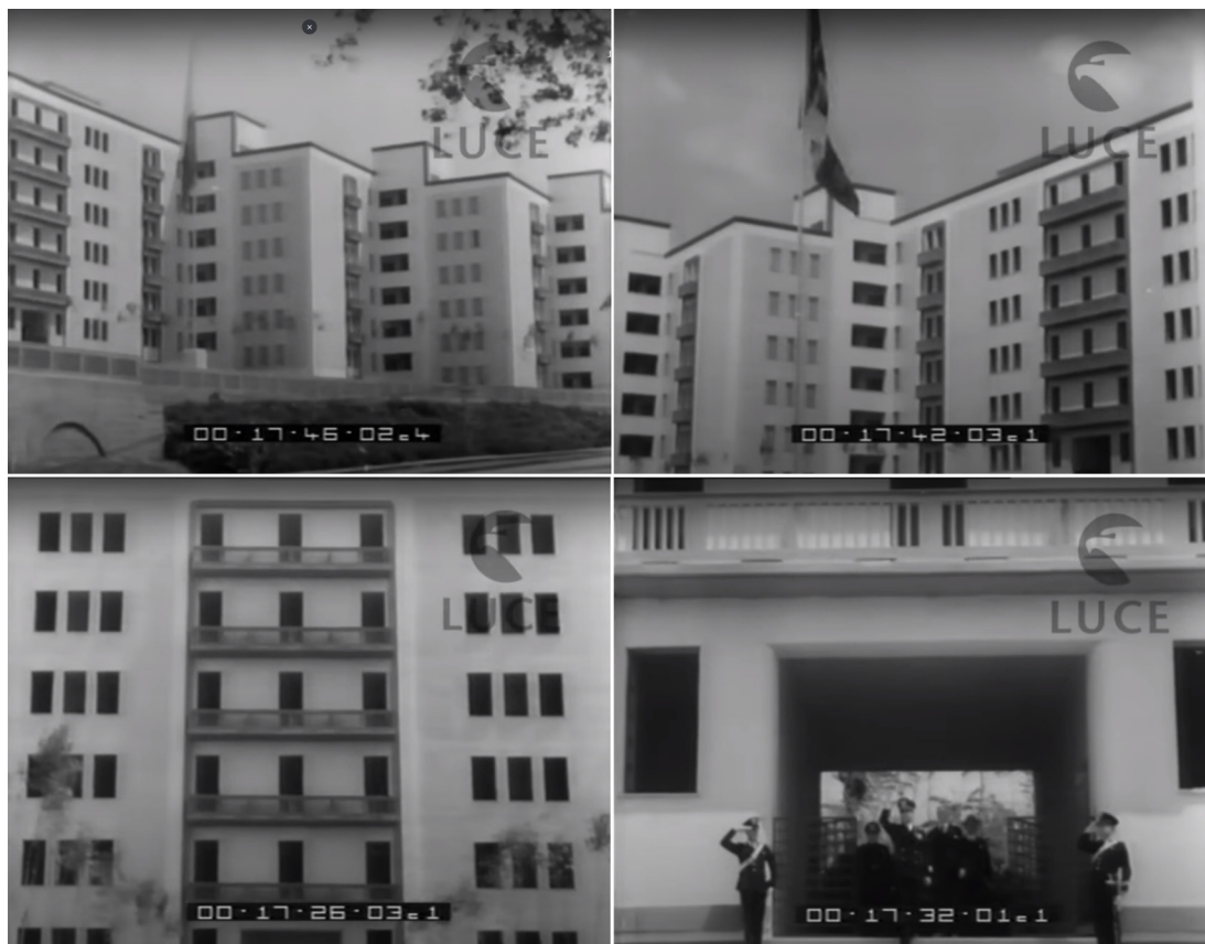
Fig. 20: Alcuni fermoimmagini dal documentario realizzato dall'Istituto LUCE per l'inaugurazione delle case operaie delle Manifatture cotoniere meridionali, 3 maggio 1939.
