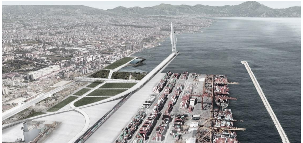
Figura 10. La stazione marittima, vista verso oriente
