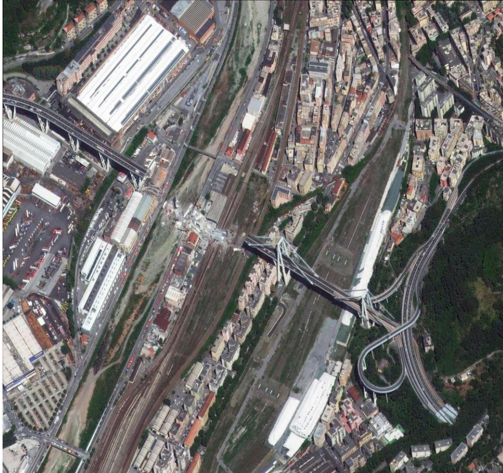
Fig. 1 – Vista satellitare del Ponte Morandi subito dopo il crollo del 14 agosto 2018
