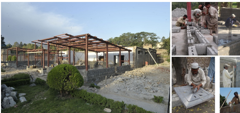
Fig. 18 – Swat Museum, struttura modulare, fase di montaggio blocco A
