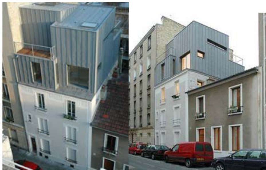
a) Veduta generale dell'intervento in copertura b) Vista del fronte principale
