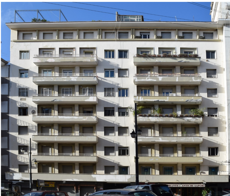
Fig. 7 – Edificio recente di sostituzione edilizia
