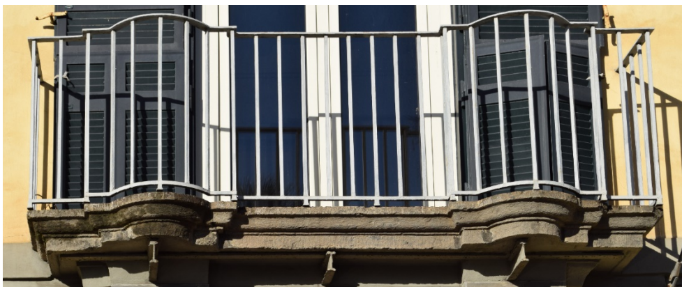
Fig. 3 – Edificio signorile ottocentesco: sporti in pietra lavica su struttura metallica
