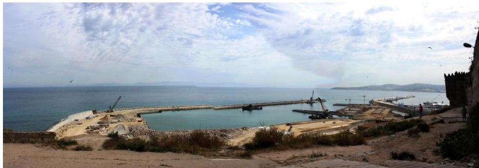
Fig. 5 – Vista sul cantiere del porto storico di Tangeri dalla Kasbah
