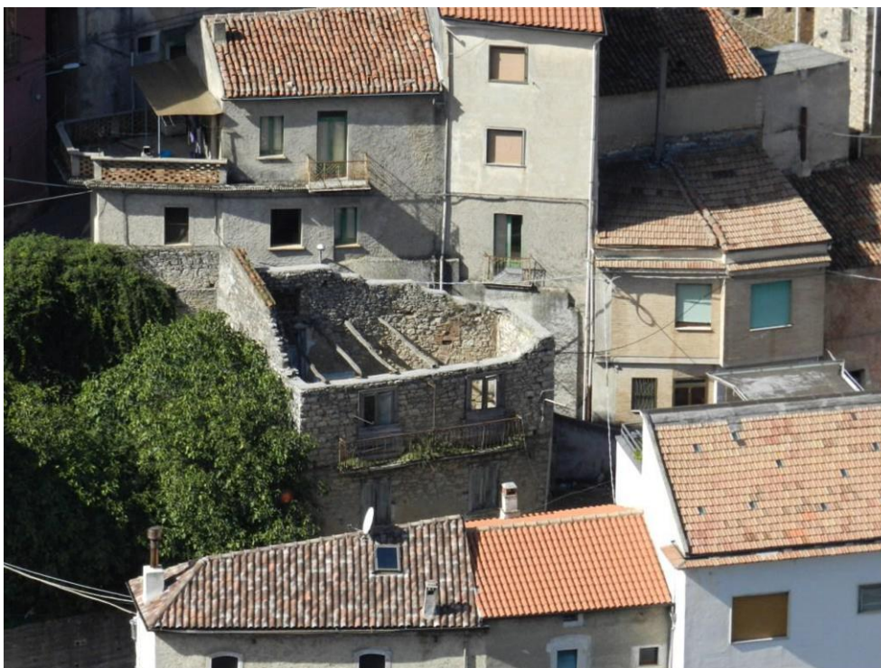
Fig. 3 – Degrado degli edifici storici
