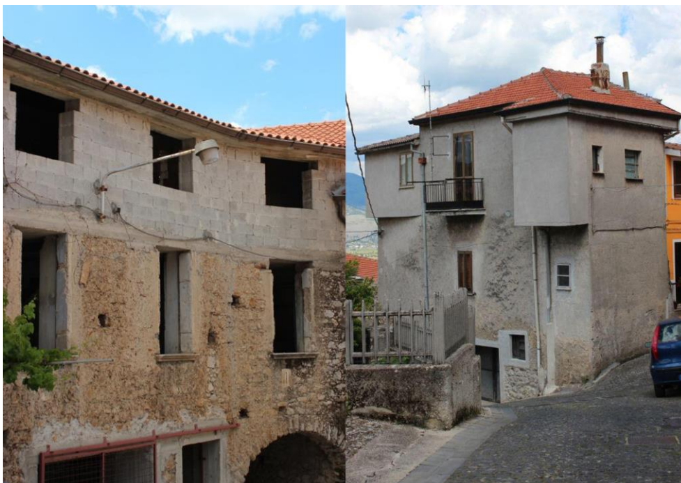
Fig. 4 – Interventi sul costruito
