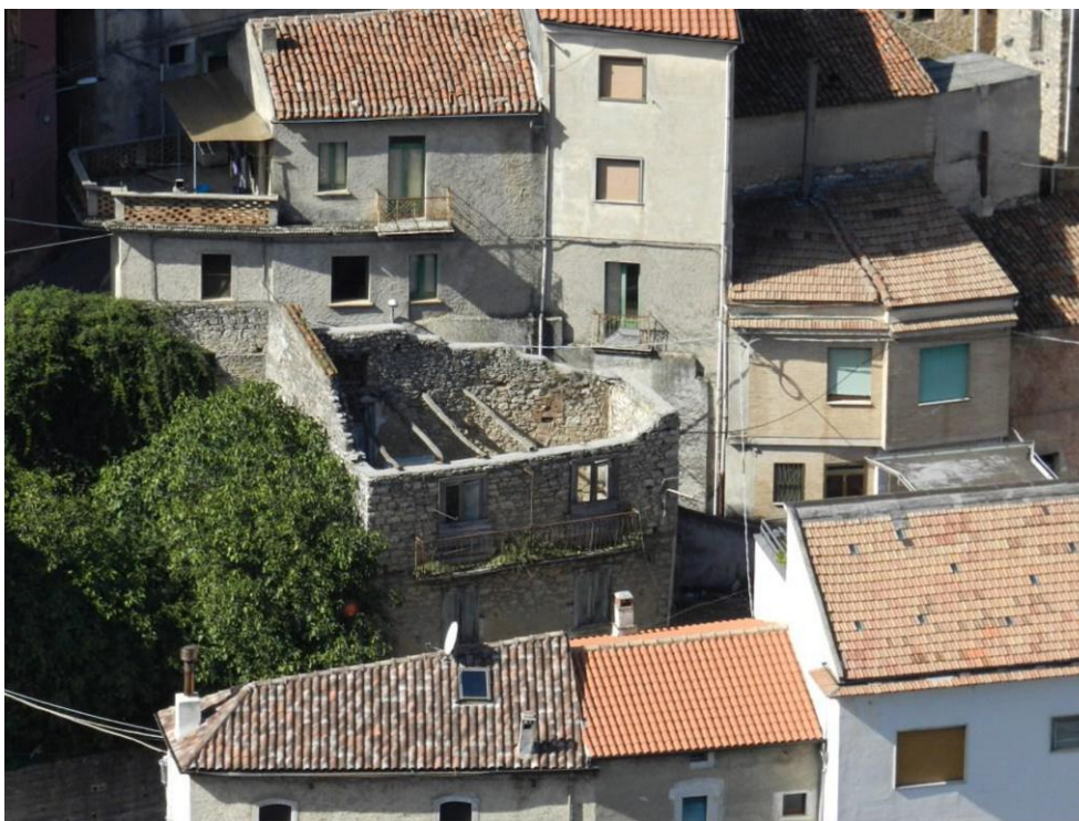
Fig. 3 – Degradato degli edifici storici
